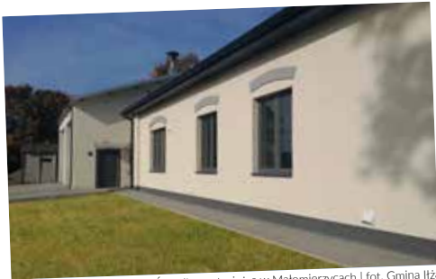
Świetlisko - strażnica w Małomierzcach | fot. Gmina Itża
